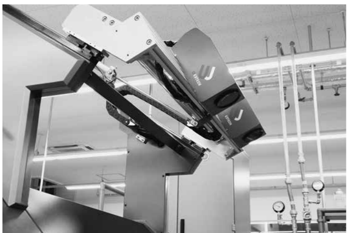
4Kカメラの品質検査装置を設置
